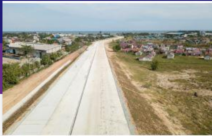
Gambar: Jalan di Kab. Penajam Paser Utara
