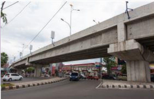
Gambar: Flyover di Kota Bandar Lampung
