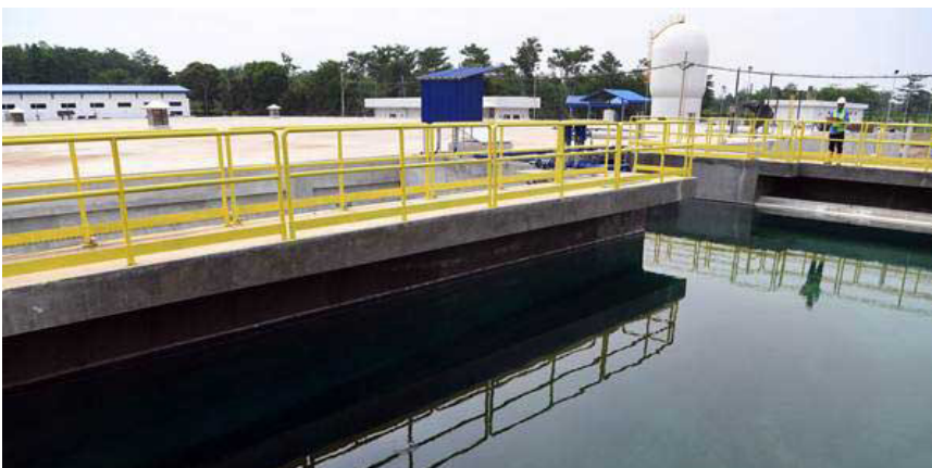
Sistem Penyediaan Air Minum (SPAM) Umbulan merupakan proyek Kerjasama Pemerintah dengan Badan Usaha (KPBU) yang bertujuan menyediakan air bersih bagi wilayah Jawa Timur
