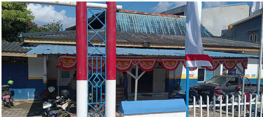
Tampak luar PDAM Tirta Sorume Kabupaten Kolaka
