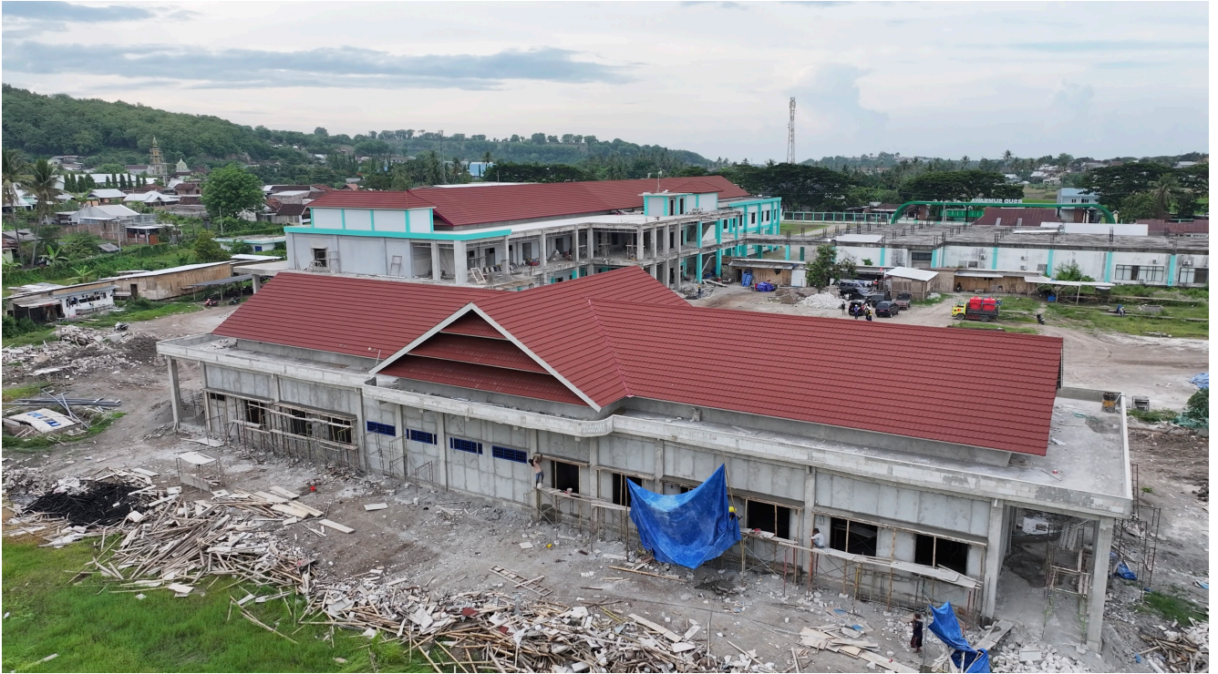
Pembangunan RSUD Sumbawa yang didanai menggunakan APBD dan APBN (Dana Alokasi Khusus Fisik)
