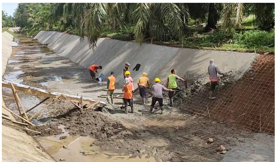
Irigasi yang dibangun dengan DAK Fisik di Kabupaten Seluma, Provinsi Bengkulu Sumber - radarbengkulu.bacakoran.co
