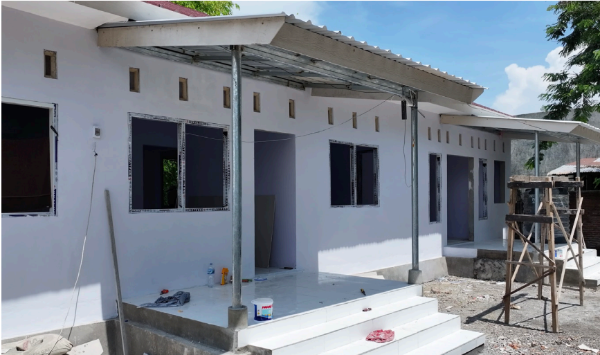
Pembangunan Puskesmas Pembantu di Kabupaten Sumbawa dengan DAK Fisik
