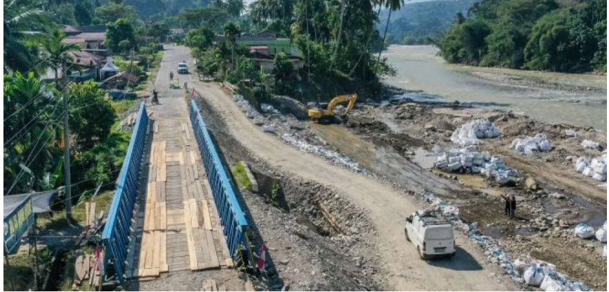
Proyek pembangunan jembatan di jalur lintas Aceh Negara Sumber - ramadhan.antaranews.com
